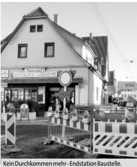
Kein Durchkommen mehr - Endstation Baustelle.
