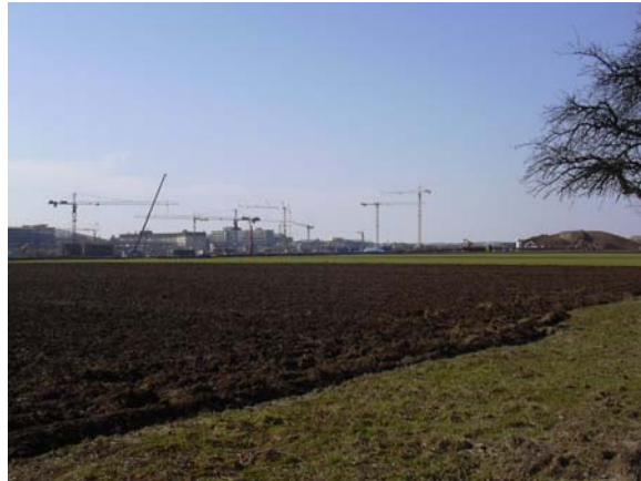
Bau der neuen Messe
